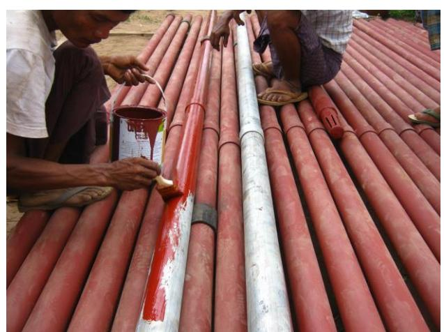
写真 12 揚水管に弁柄塗布作業
