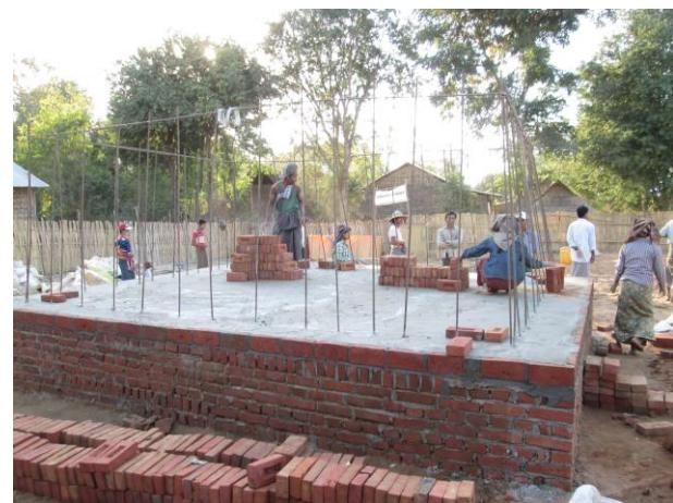
写真 3 貯水タンク建設工程
