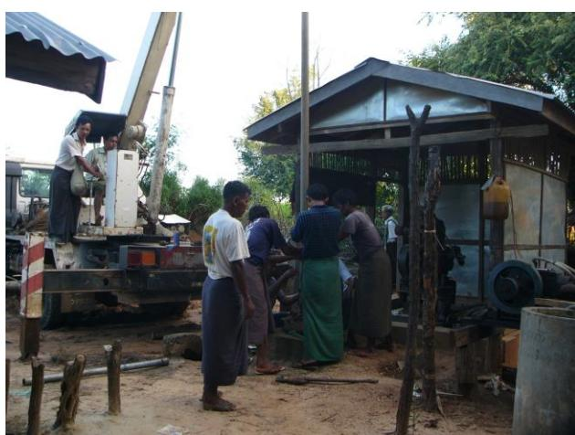
写真 11 ポンプ及び揚水管の取出し作業
