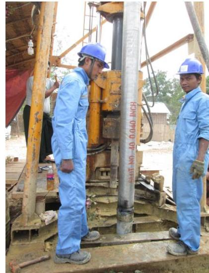
写真 2 スクリーンパイプの設置
