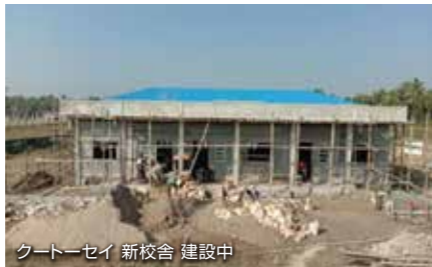
クートーセイ 新校舎 建設中
