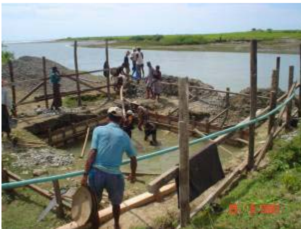
B側橋台基礎工事に用掘削作業 (9月29日)
