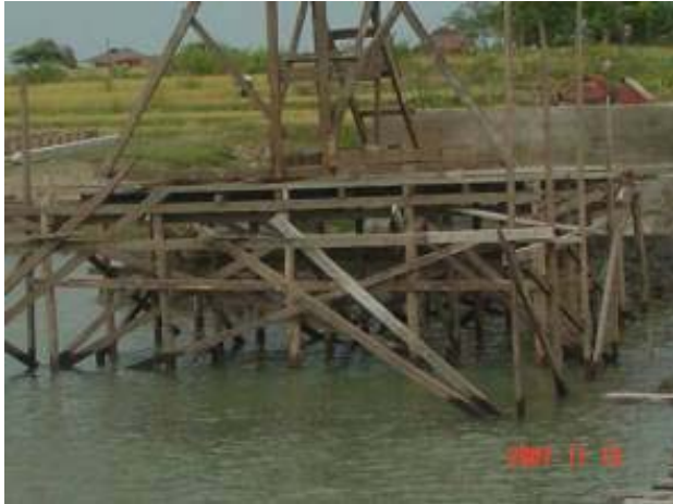
第1橋脚杭打設用プラットフォーム (11月15日)
