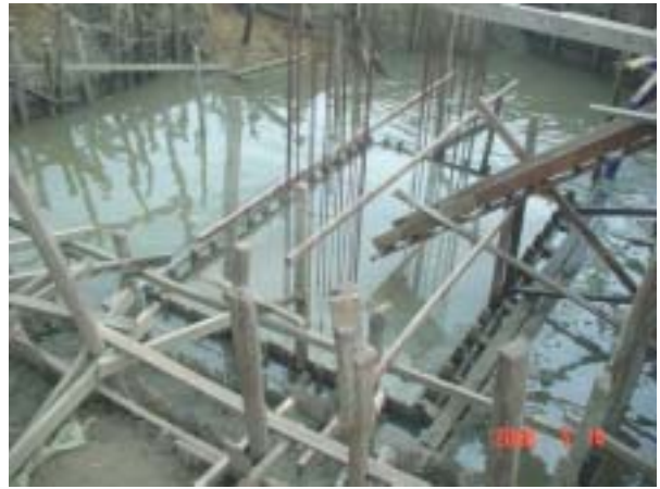
第3橋脚パイルキャップ(5月14日)
