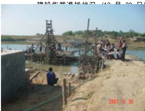
建設作業進捗状況 (12月30日)
