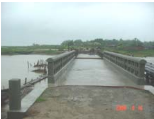
第3橋脚とB側橋台スラブ(6月16日)
