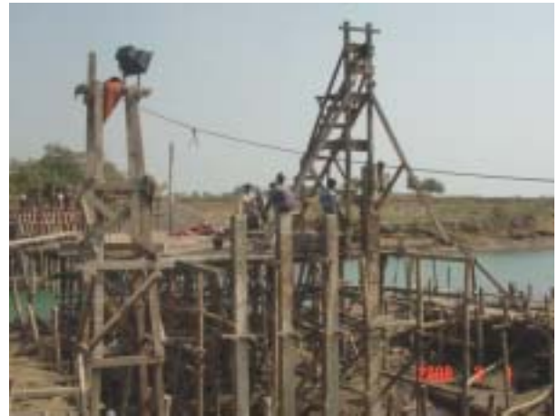
第4橋脚杭打設(3月1日)
