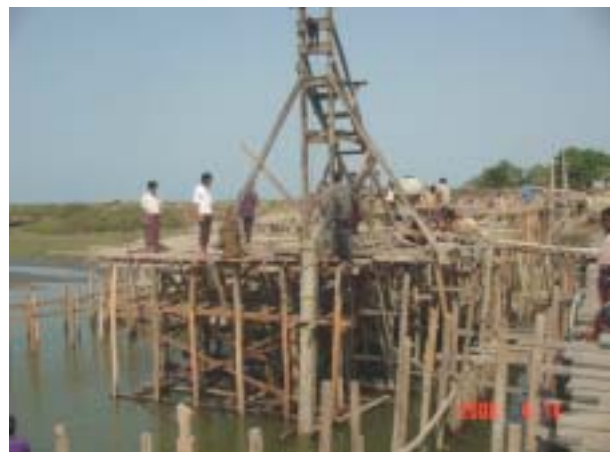
第3橋脚杭打節(4月14日)
