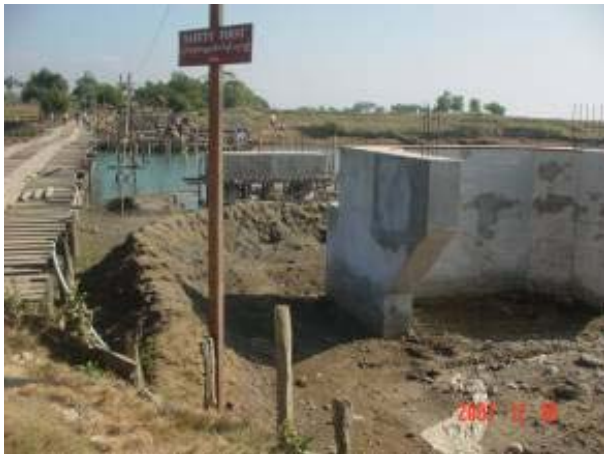
A 側橋台と第1橋脚 (12月30日)
