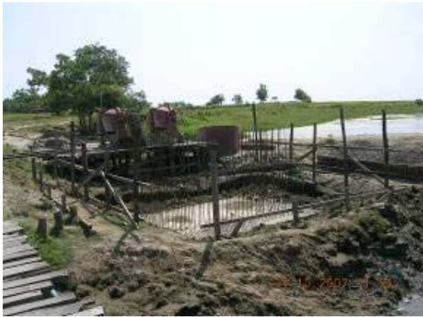
B側橋台B側基礎工事 (10月31日)
