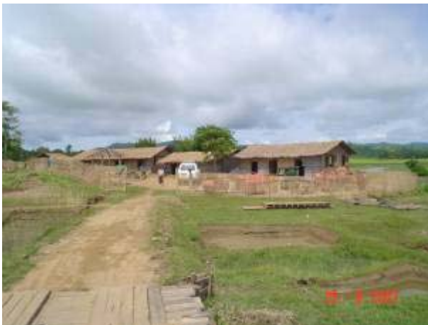
サイト建設事務所 (9月29日)
