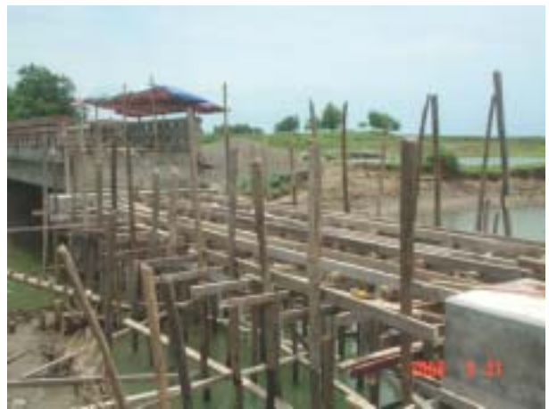
第3橋脚と第4橋脚木材型枠作業(5月31日)
