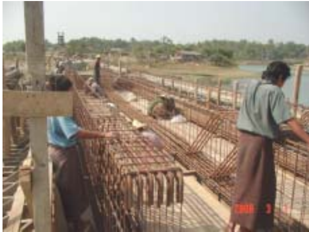
B側橋台と第4橋脚鉄筋配列 (3月1日)
