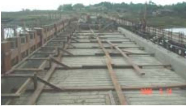
B側橋台と第4橋脚欄干進捗(5月14日)
