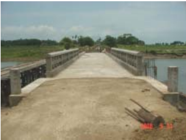
A側橋台と第1橋脚欄干(5月31日)
