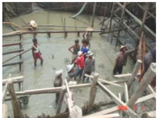
第3橋脚パイルキャップ(5月1日)
