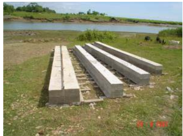
成型コンクリート基礎杭 (9月29日)
