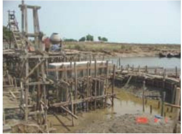
第2橋脚付近(4月1日)
