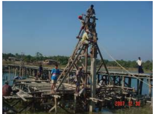
第4橋脚基礎杭打設作業 (12月30日)
