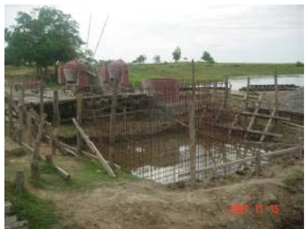
B側橋台付近(11月15日)
