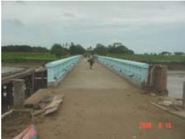
A 側橋台から(8月15日)
