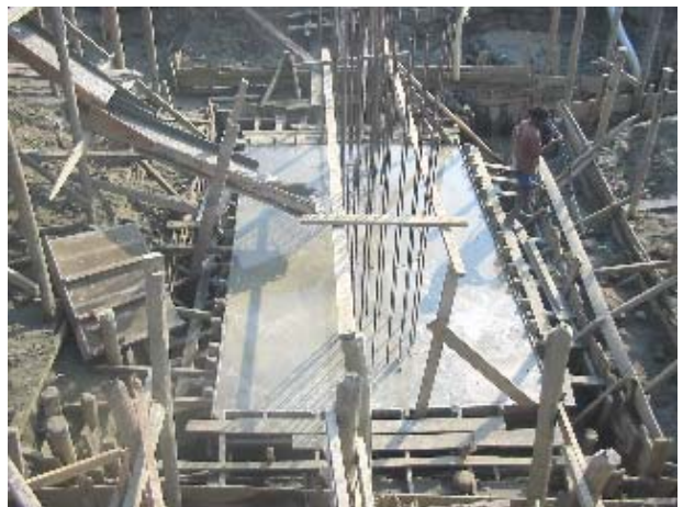
第2橋脚用パイルキャップ(3月15日)
