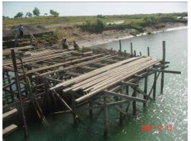
第4橋脚杭打設用プラットフォーム建設(12月13日)
