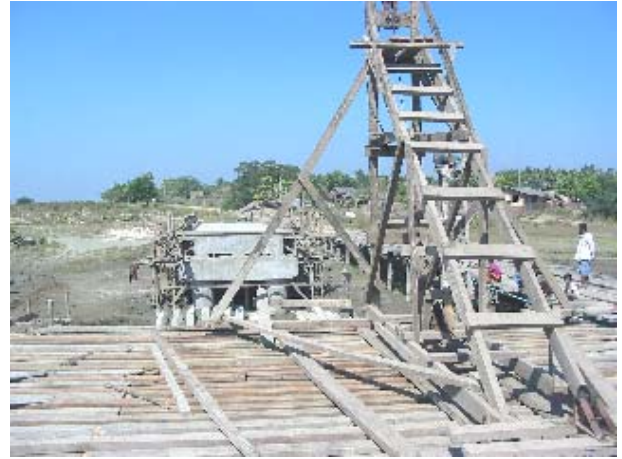
第2橋脚プラットフォーム(2月14日)
