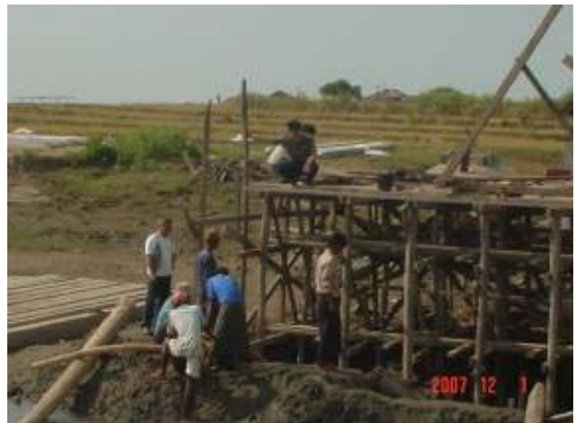
第1橋脚杭打設作業 (12月1日)
