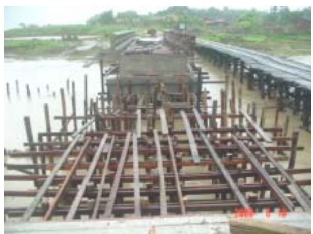
第2橋脚と第3橋脚木材型枠(6月16日)
