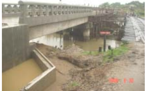
B側橋台防護壁(6月30日)
