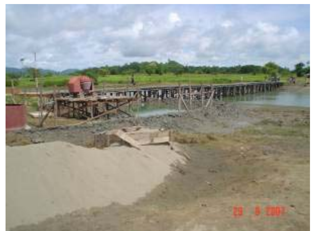
A側橋台杭打設用プラットフォーム建設(9月29日)
