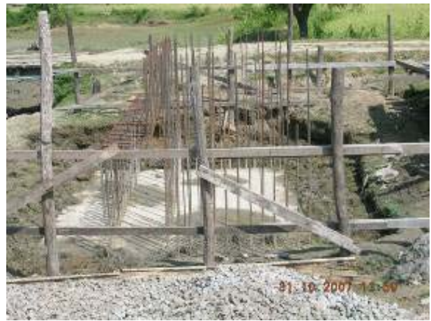
B側橋台B側基礎工事 (10月31日)
