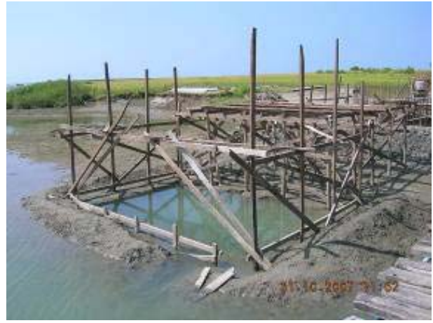
第1橋脚基礎工事 (10月31日)
