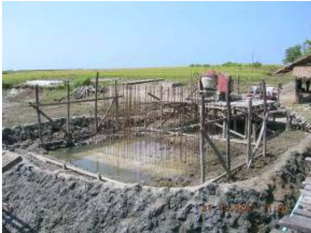
A側橋台パイルキャップ (10月31日)
